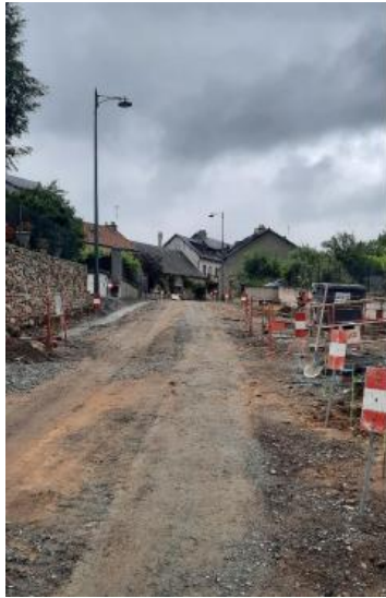
Travaux traversée du bourg
