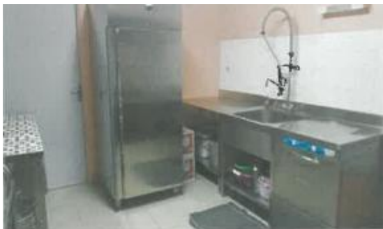
Mise aux normes de la cuisine
