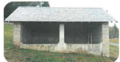
Restauration des lavoirs
