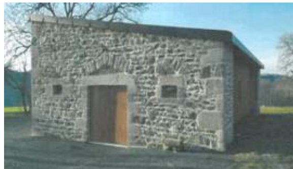
Restauration grange auvergnate pour local technique
